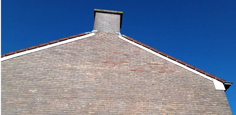
Foto 2 Typische kopgevel zonder open stootvoegen en met trespa windveren.
