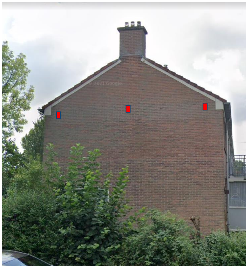
Figuur 14 Een voorbeeld van de locatie van open stootvoegen bij de Stroom 28.
