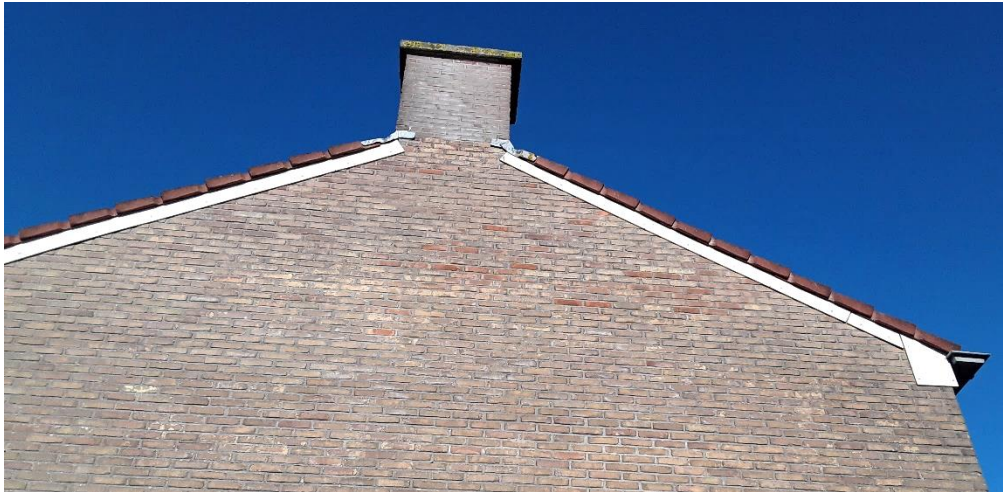
Foto 5 Typische kopgevel zonder open stootvoegen en met trespa windveren.
