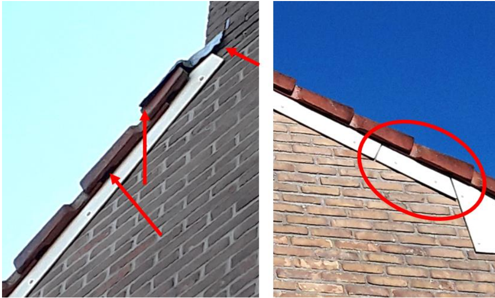
Foto 1 Strakke gevelpannen met voor vleermuizen geschikte openingen onder pannen en loodslab (links) en strakke gevelpannen met kieren tussen trespa delen (rechts).
