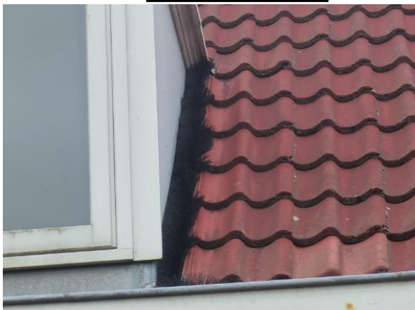
Foto 20 Gaas in de goten (boven) en borstels geplaatst bij een dakkapel (onder).
