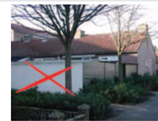
Bijgebouwen op het achtererf gemaakt van golfplaten. Golfplaten zijn alleen toegestaan als dakbedekking; bijzonder, moet getoetst worden.
