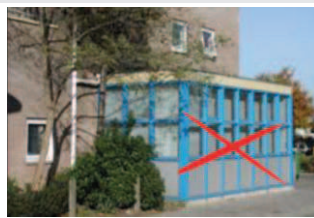
Aanbouw die in materiaal- niet goed aansluit: bijzonder, moet getoetst worden.
