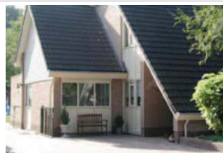
Aanbouw met materiaal- en kleurgebruik overeenkomstig het hoofdgebouw en dakhelling gelijk aan het hoofdgebouw: gewoon.
