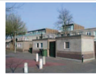
Bijgebouwen met materiaal- en kleurgebruik overeenkomstig het hoofdgebouw: gewoon.
