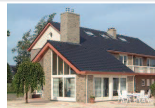
Materiaalgebruik van de aanbouw is overeenkomstig het hoofdgebouw: gewoon.
