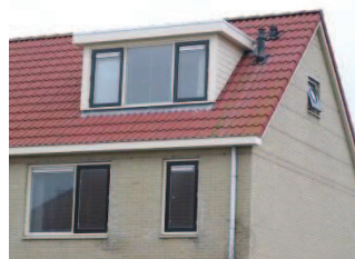
Dakkapel die in materiaal- en kleurgebruik en maatvoering overeenkomstig het hoofdgebouw is: gewoon.
