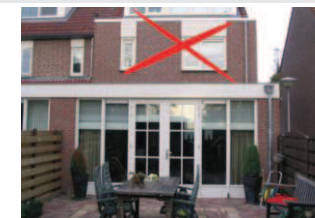
Uitbouw die in hoogte en detaillering niet goed aansluit: bijzonder, moet getoetst worden.
