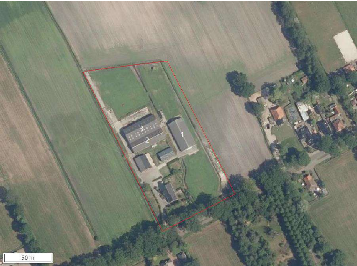
De te slopen gebouwen gemarkeerd met de cijfers 1, 2 en 3.
