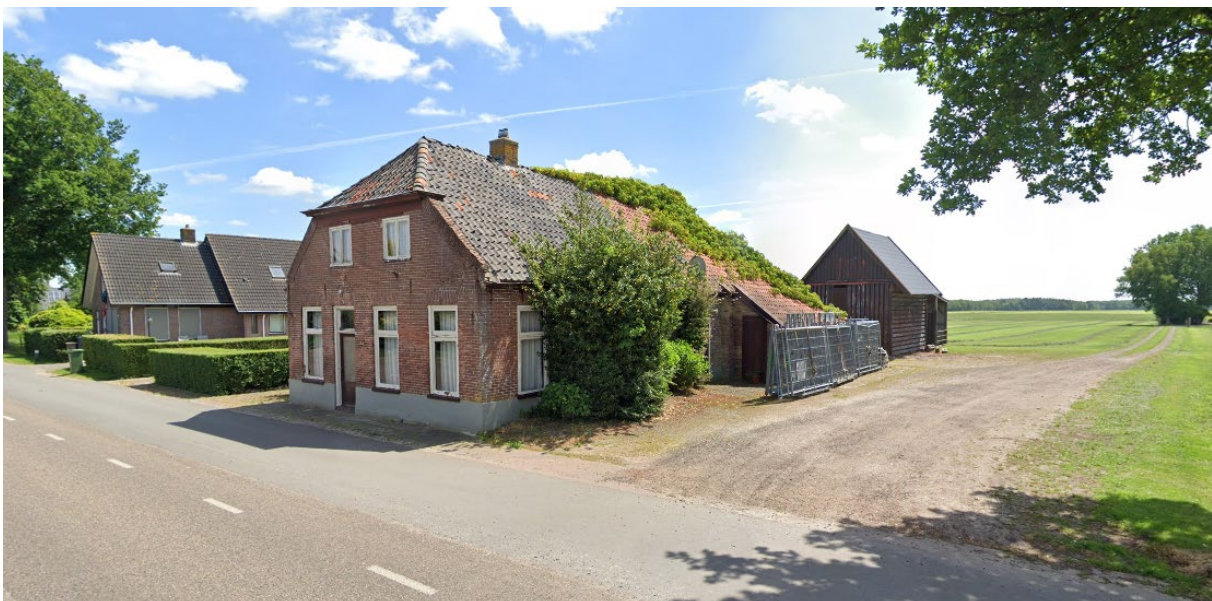
Afbeelding 4: bestaande bebouwing (bron: Google maps)
