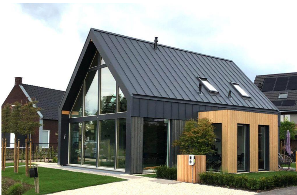
Schuurwoning met roefdak/felsdak
