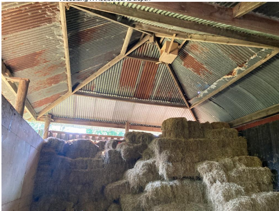
• Afbeelding 7: Hooischuur te slopen
