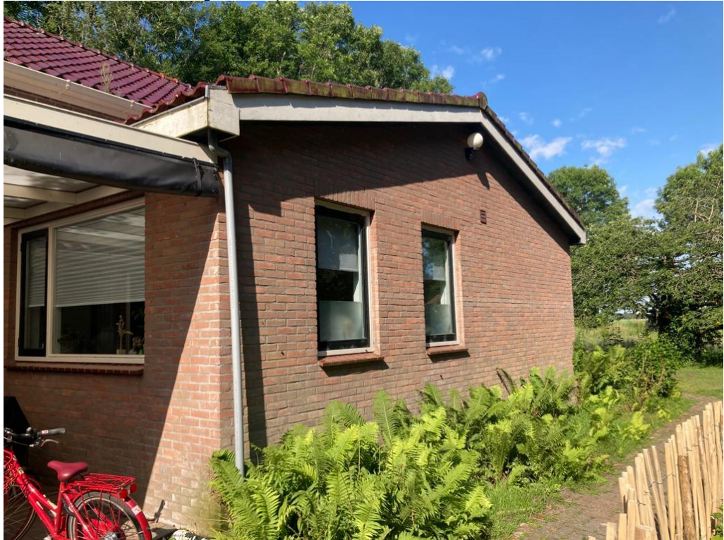
• Afbeelding 13: Te slopen woonhuis
