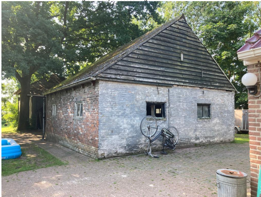
• Afbeelding 3: Te slopen bebouwing
