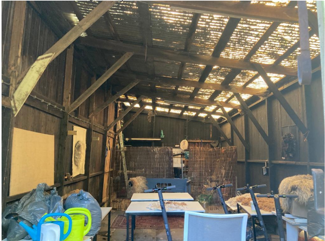
• Afbeelding 18: Te slopen schuur
