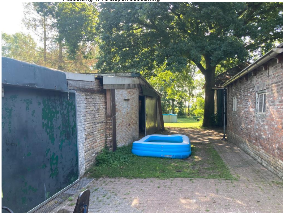
• Afbeelding 4: Te slopen bebouwing
