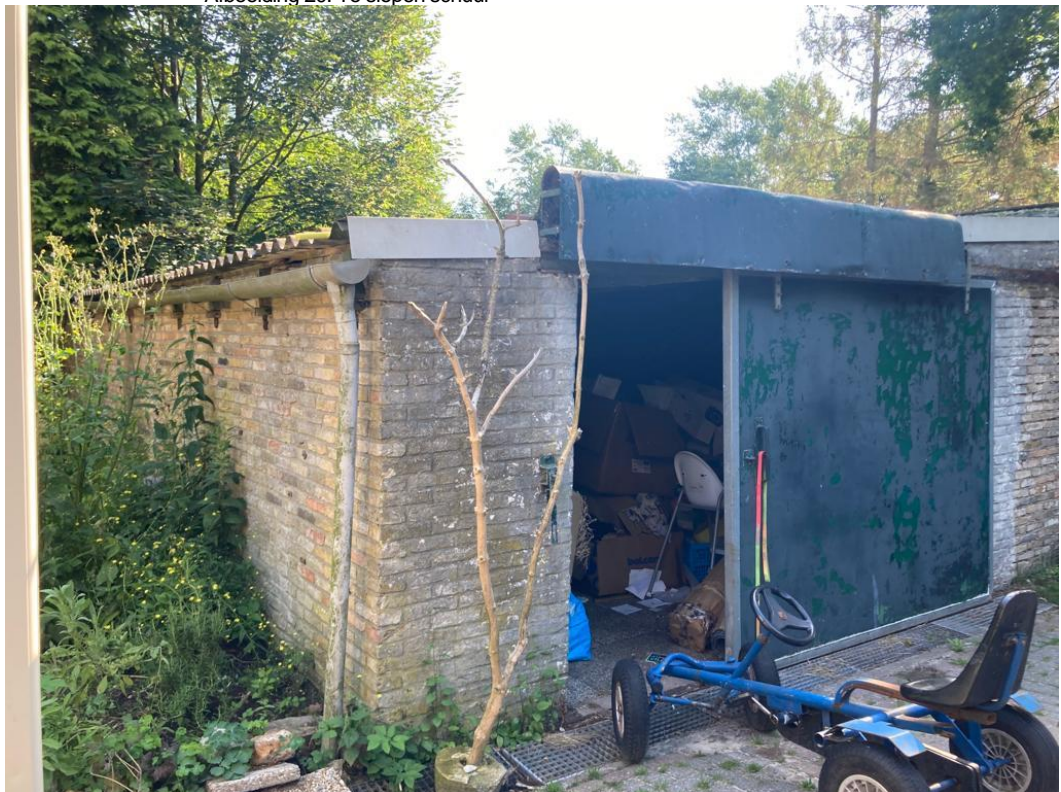
• Afbeelding 20: Te slopen schuur
