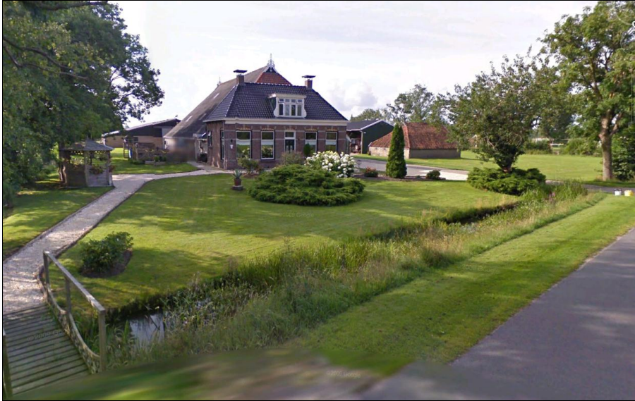
Figuur 4. De bestaande bebouwing aan de Idzardaweg 76
