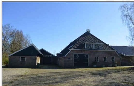
Afbeelding 1.4. Schuur met stallen vanaf het noorden
