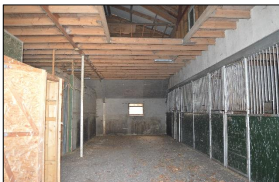
Afbeelding 2.14. Binnenzijde schuur met stallen.
