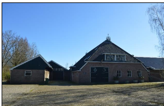
Afbeelding 2.4. Schuur met stallen vanaf noorden.
