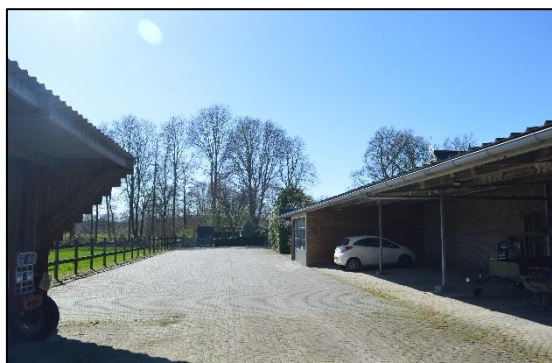
Afbeelding 2.5. Achterzijde erf met overkapping.
