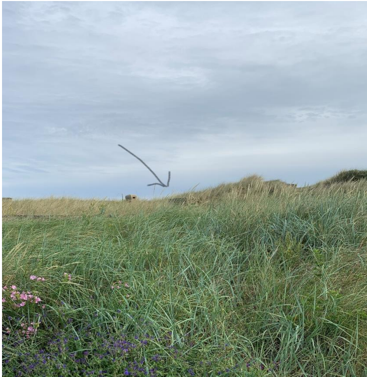
Airco buitenunit west
