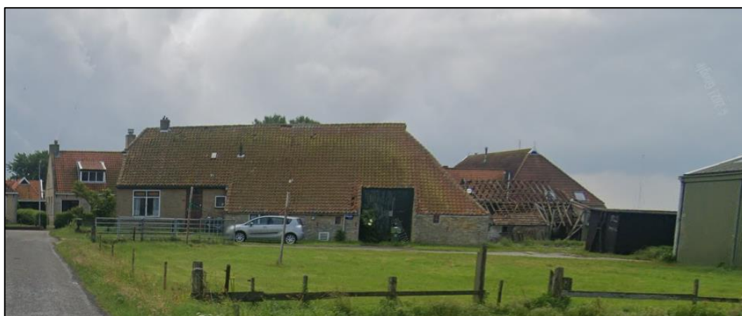
Figuur 2.2 Aanzicht op de boerderij (rechts in de achtergrond de wierschuur) (2019)
