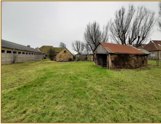
Afbeelding. 2.1: Schuur 1 rondom gedicht met hooibalen.
