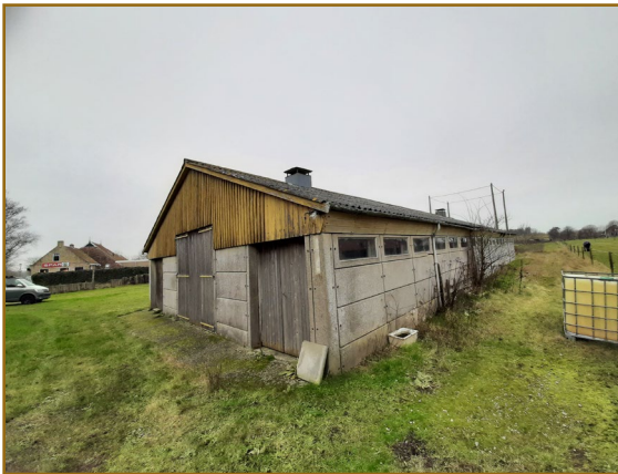
Afbeelding. 2.3: Zuidelijke zijde van schuur 4.
