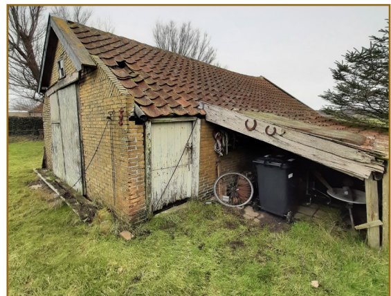
Afbeelding. 2.6: Zuidelijke zijde van schuur 2.
