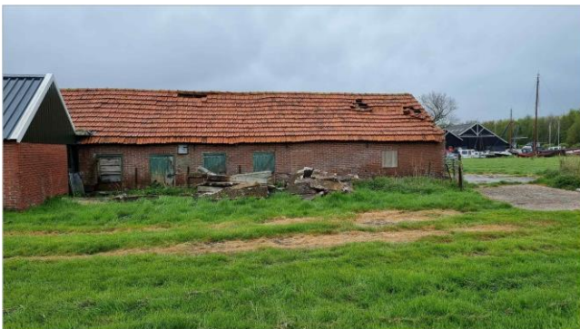
Exterieur meest westelijke stal. Foto richting zuiden.
