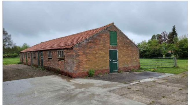
Exterieur te slopen noordelijke stal. Foto richting westen.
