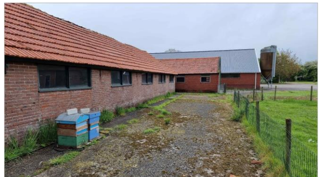
Exterieur meest westelijke stal en aangrenzende schuur met opslag. De locatie met het RVS dak op de achtergrond wordt niet gesloopt. Foto richting oosten.
