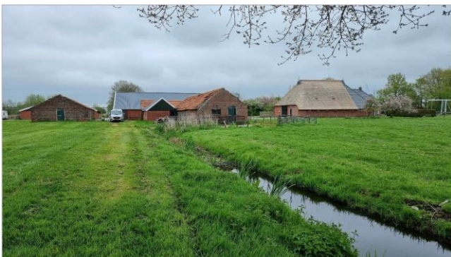
Overzichtsfoto plangebied met op de voorgrond de te slopen opstallen en helemaal rechts de boerderij Buitenstvallaat 11. Foto richting oosten.
