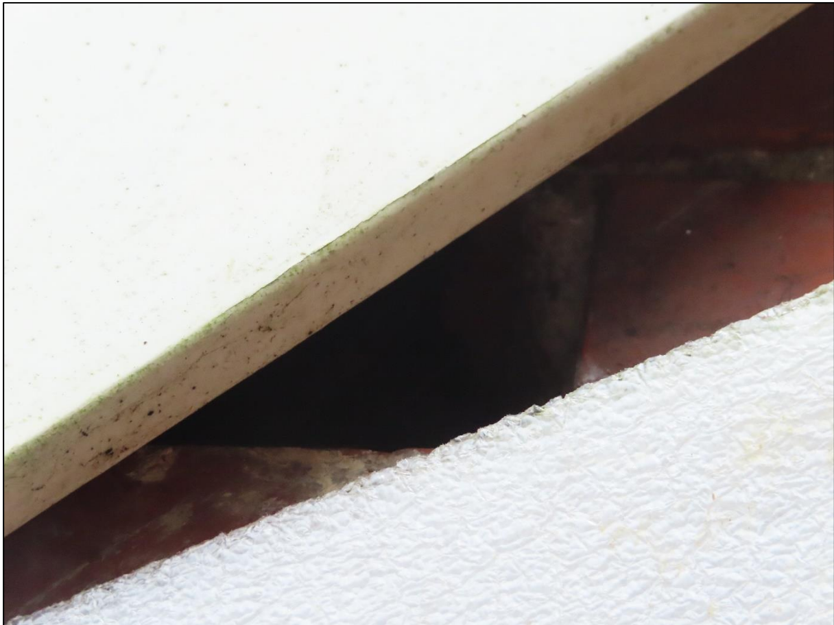
Figuur 2.7. In de muren van de twee woningen werden openingen aangetroffen waardoor een eventuele spouwmuur toegankelijk is voor vleermuizen.
