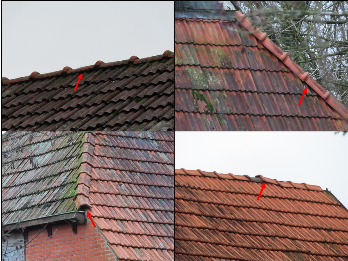
Figuur 2.4. Onder gegolfde dak- en nokpannen op de twee te slopen woningen zijn (doorgangen tot) voor huismussen geschikte nestlocaties aangetroffen.
