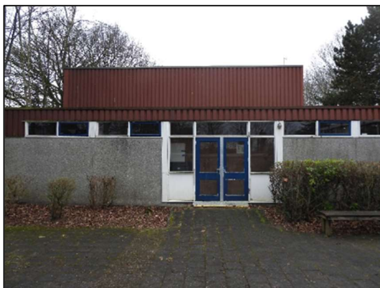
Afbeelding 1.6. Gebouw van gymzaal.
