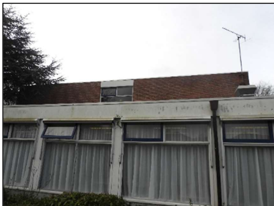
Afbeelding 1.4. Houten kozijnen en open stootvoegen
