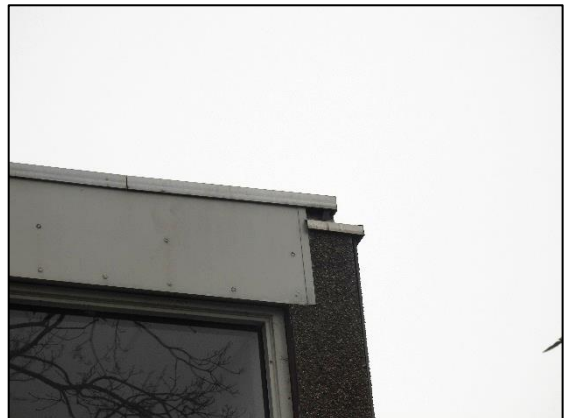
Afbeelding 2.3. Opening langs afwerking daklijst.
