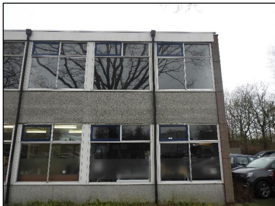
Afbeelding 2.4. Houten kozijnen.
