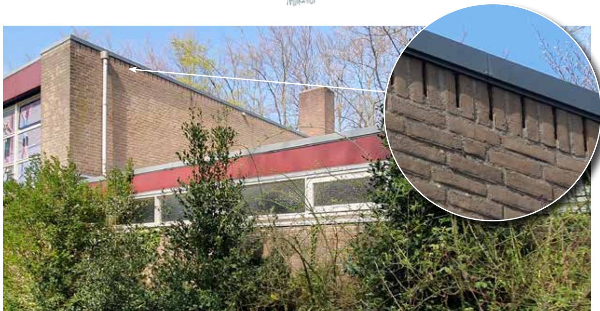
Figuur 20. Invliegopeningen open stootvoegen, oostzijde.
