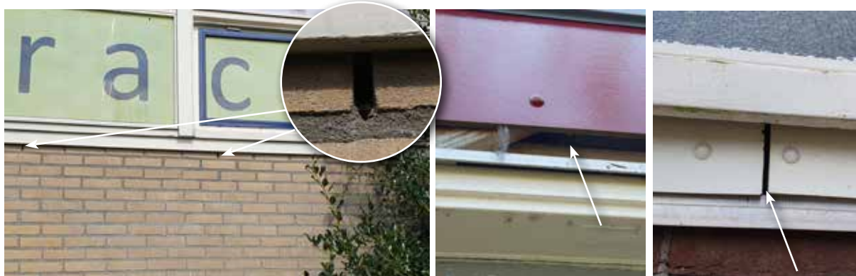
Figuur 21. Invliegopeningen open stootvoegen, zuidzijde.
