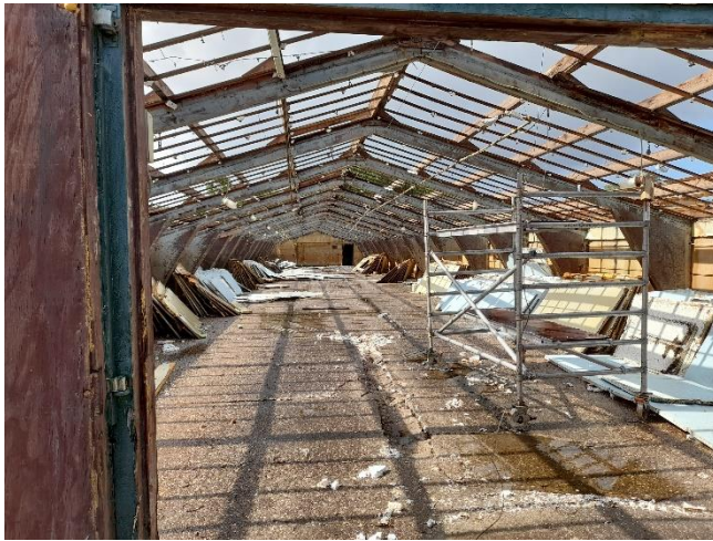
Figuur 2.5: Binnenzijde oostelijke opstal.
