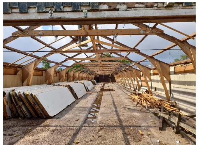
Figuur 2.4: Binnenzijde van de centraal gesitueerde opstal.
