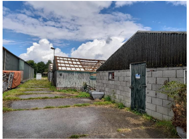
Figuur 2.6: Voorzijde van de drie zuidelijke opstallen.
