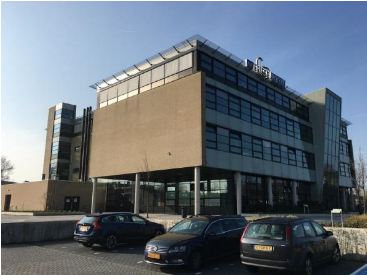
Figuur 3. Het te slopen schoolgebouw D.
