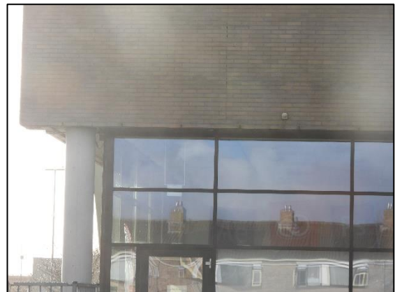
Afbeelding 2.7. Stootvoegen onder in de muur.
