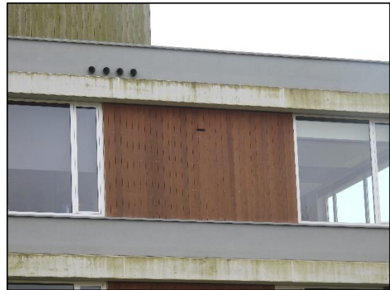
Afbeelding 2.19. Mitigatie vleermuizen in gebouw ten zuiden van plangebied.
