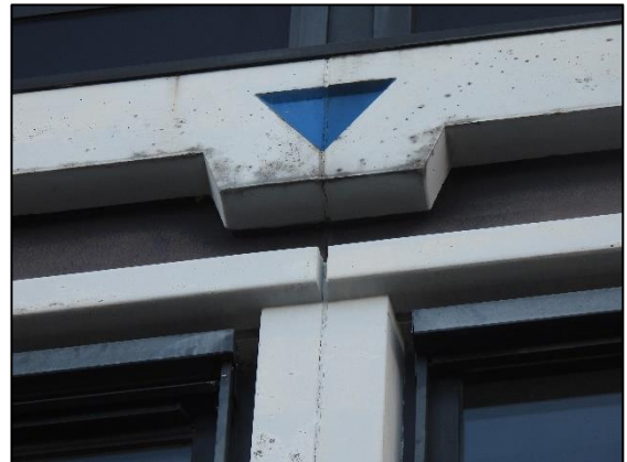
Afbeelding 2.11. Ruimte achter lijstwerk rondom het schoolgebouw.
