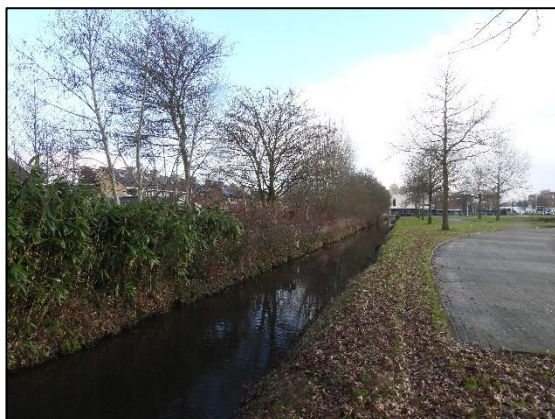
Afbeelding 2.23. Watergang naast parkeerplaats.
