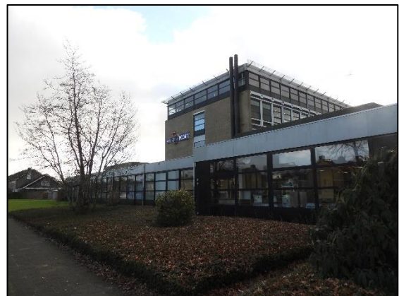
Afbeelding 2.9. Noordkant schoolgebouw met struikgewas.
