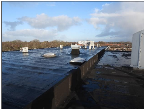
Afbeelding 2.4. Platte dak van schoolgebouw D.
