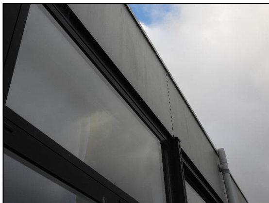
Afbeelding 2.8. Ruimte achter platen aan noordkant van schoolgebouw.
