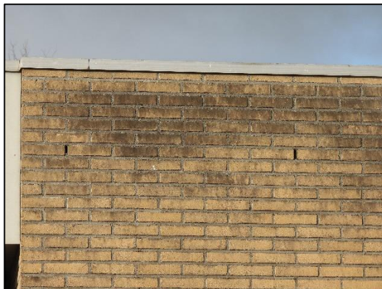
Afbeelding 2.6. Stootvoegen boven in de muur.
