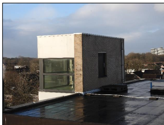
Afbeelding 2.3. Stootvoegen in muur op het dak.
