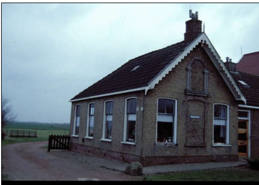
Figuur 4. De brugwachterswoning aan de Kraenlânswei
