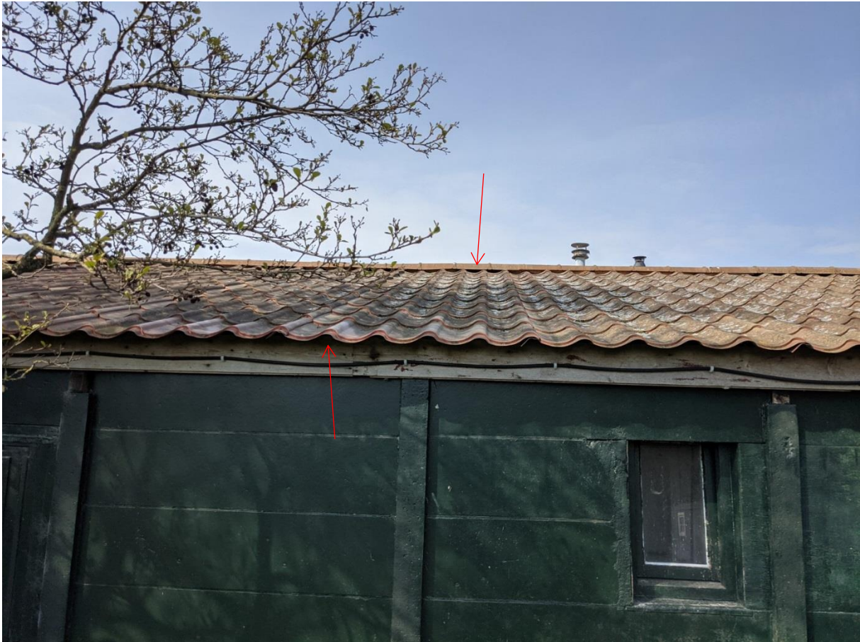
Figuur 6. Dak plangebied met potentiële invliegmogelijkheden onderdakrand golfplaten en nok..
