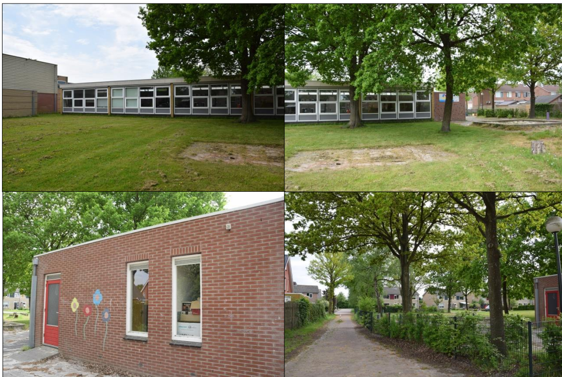
Foto's 5 t/m 8. Boven; de zuidzijde van het gebouw. Onder; de oostzijde van het gebouw en het pad ten oosten van het terrein
