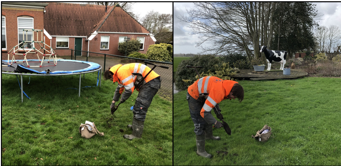
Figuur 8: Tijnje, Heawei 38 en 44: Foto's van het uitvoeren van de boringen. Links boring 3 in het noordelijke plangebied en rechts boring 23 in het zuidelijke plangebied.
