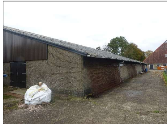
Afbeelding 2.3. Zuidwestzijde te slopen schuur.
