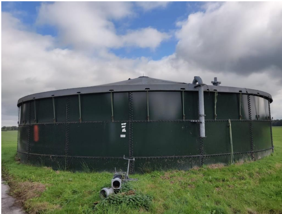
Figuur 4.3. De te slopen mestsilos.
