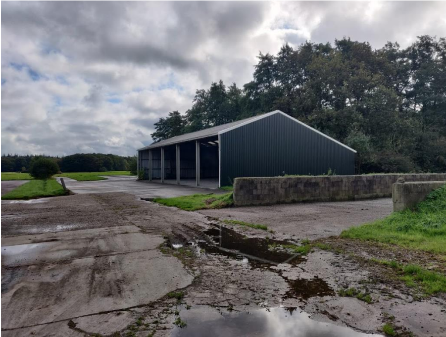
Figuur 4.1. Overzichtsfoto van (een deel van) het plangebied met de te demonteren schuur en 1 van de sleufsilo's.
