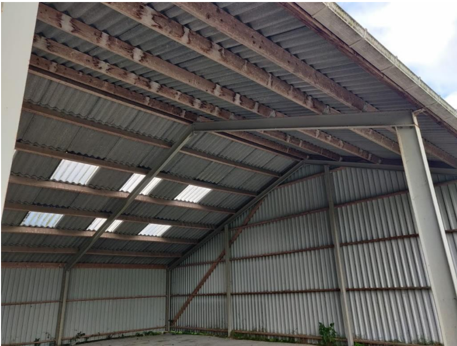
Figuur 4.2. De binnenkant van de schuur die gedemonteerd en verwijderd zal worden.
