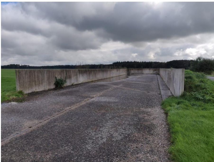
Figuur 4.4. Eén van de te verwijderen sleufsilo's.
