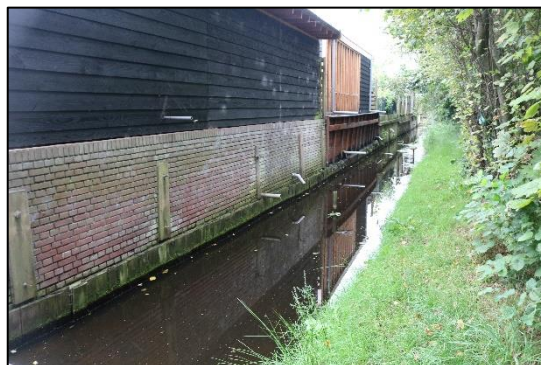
Afbeelding 2.17. Beschoeiing zuidelijke watergang.
