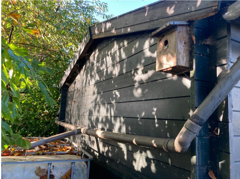
• Afbeelding 15: Achterzijde te slopen tuinhuisje
