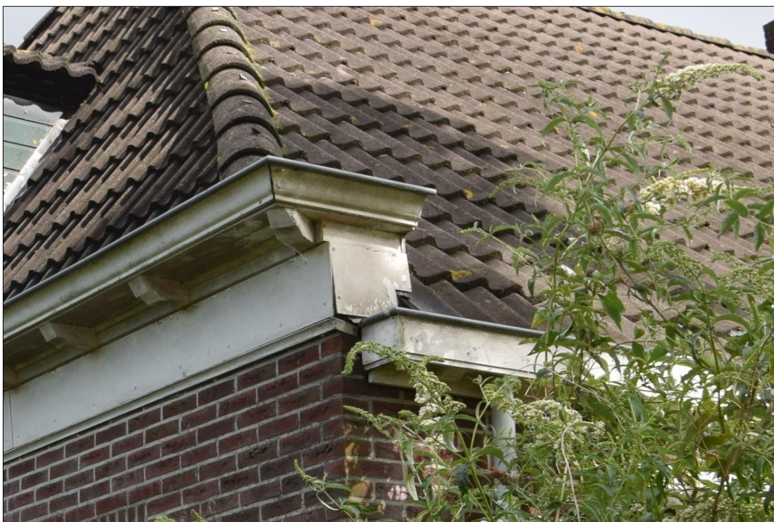
Foto 7. Een opening in het beschadigde boeiboord aan de voorzijde van de woning in deelgebied 2 van het plangebied
