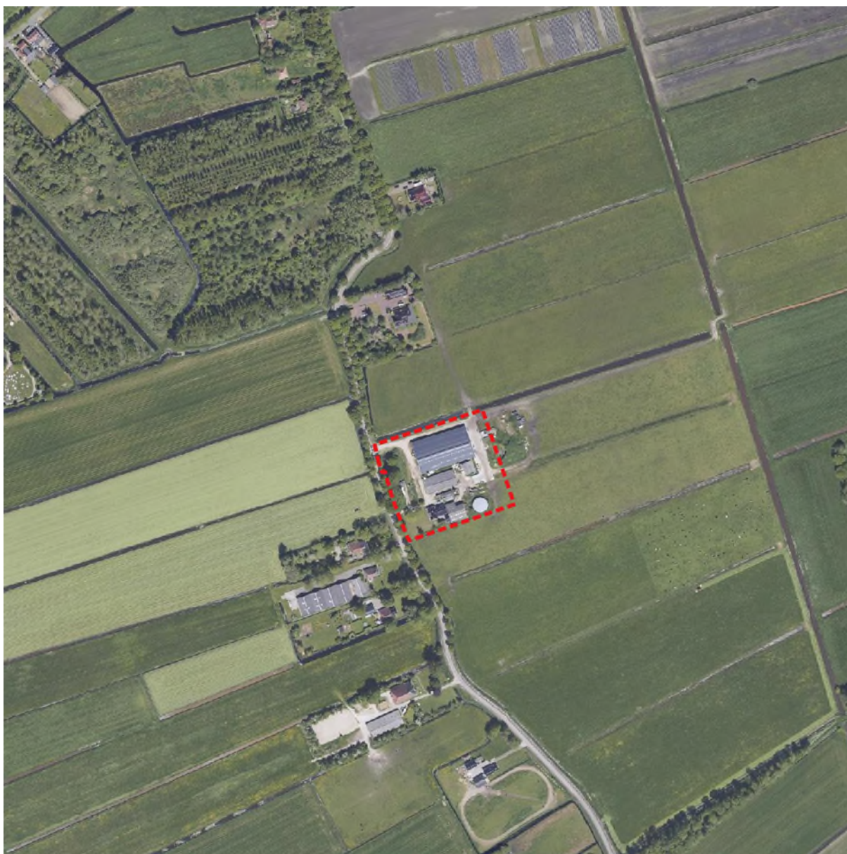
Figuur 2 Luchtfoto huidige situatie
