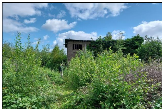
Figuur 2.2. Westzijde van het gebouw.
