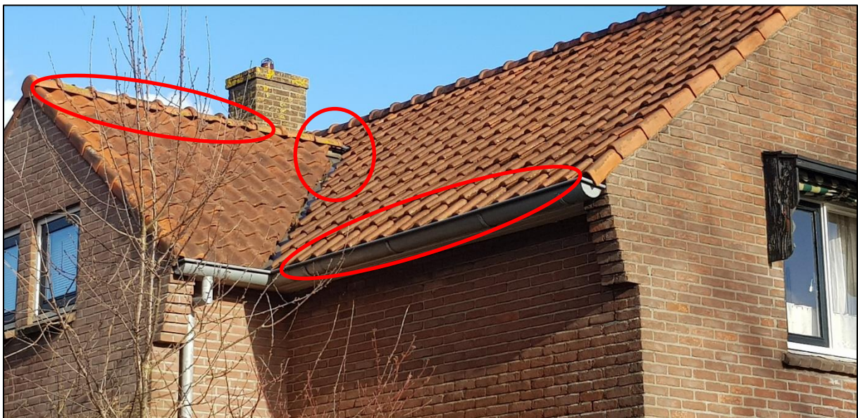
Figuur 1. Potentiële broedlocaties voor huismus en gierzwaluw onder de dakpannen bij woning Badweg 2.
