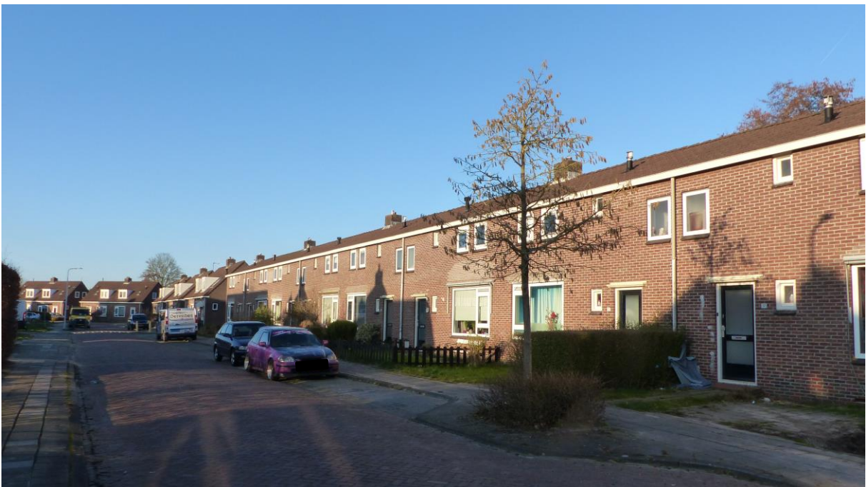
Figuur 1.4 De woningen aan de Geert van der Zwaagstrjitte 23 tot en met 37 zijn rijwoningen.
