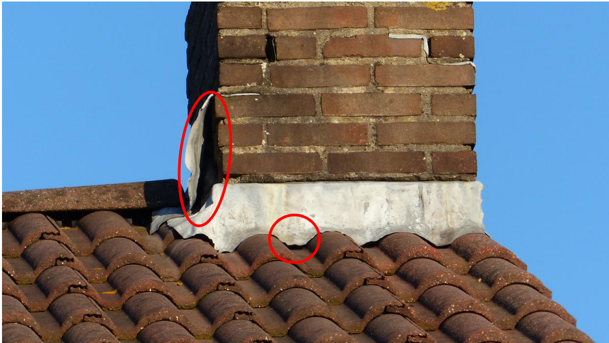
Figuur 4.5 De loodslabben rond de schoorstenen bieden geschikte openingen voor vleermuizen.
