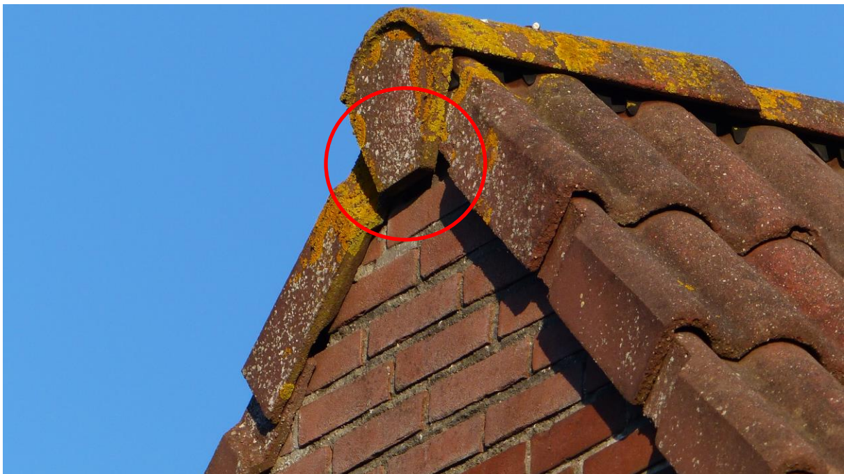
Figuur 4.2 Onder de nokvorsten van de twee-onder-een-kap woningen is geschikte ruimte aanwezig voor gierzwaluw en vleermuizen om het dakvlak te bereiken.
