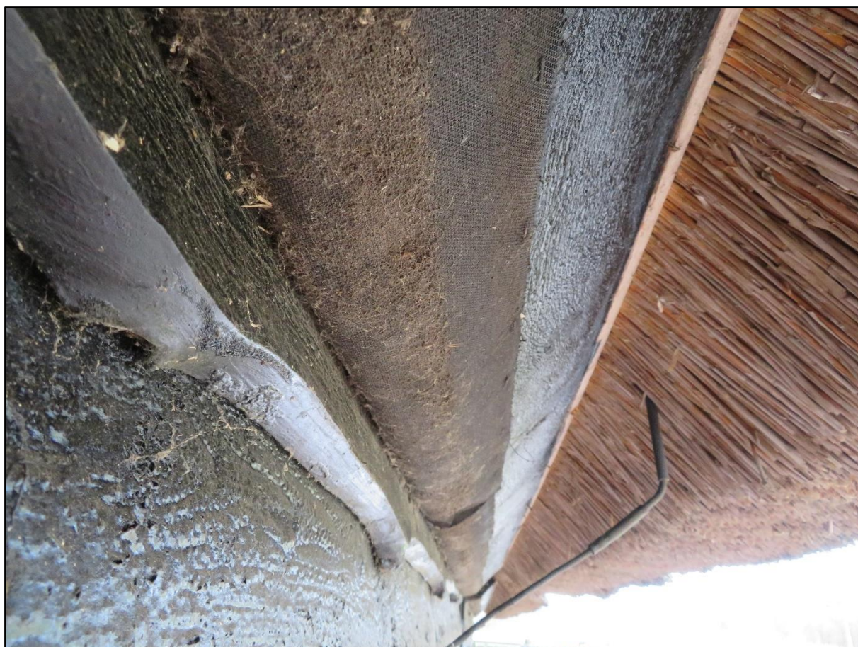
Afb 16: Ook in de aansluiting met het dak geen openingen
