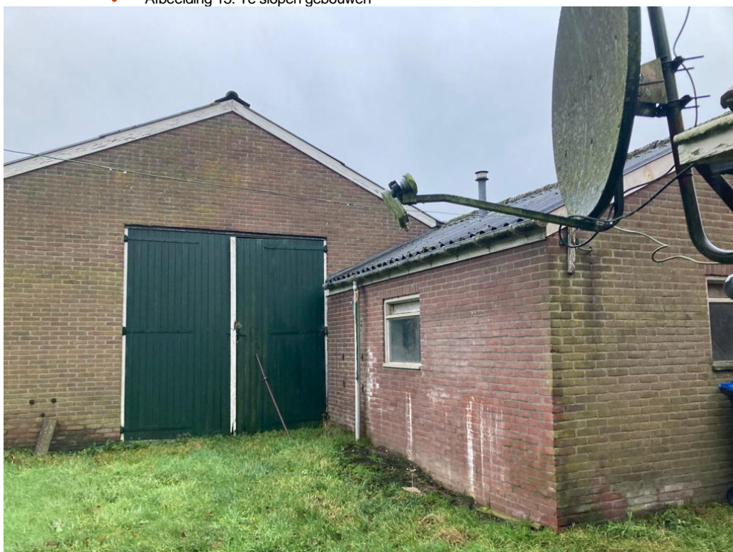
• Afbeelding 15: Te slopen gebouwen
