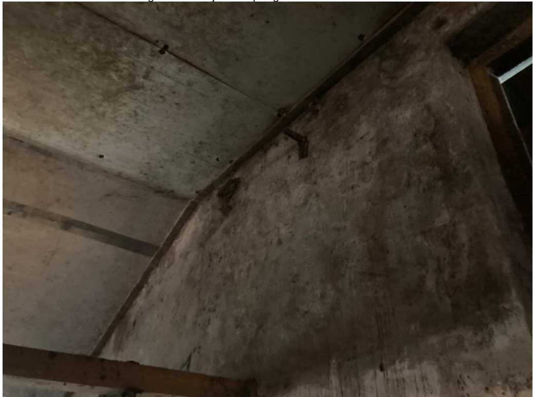
• Afbeelding 13: Binnenzijde te slopen gebouw
