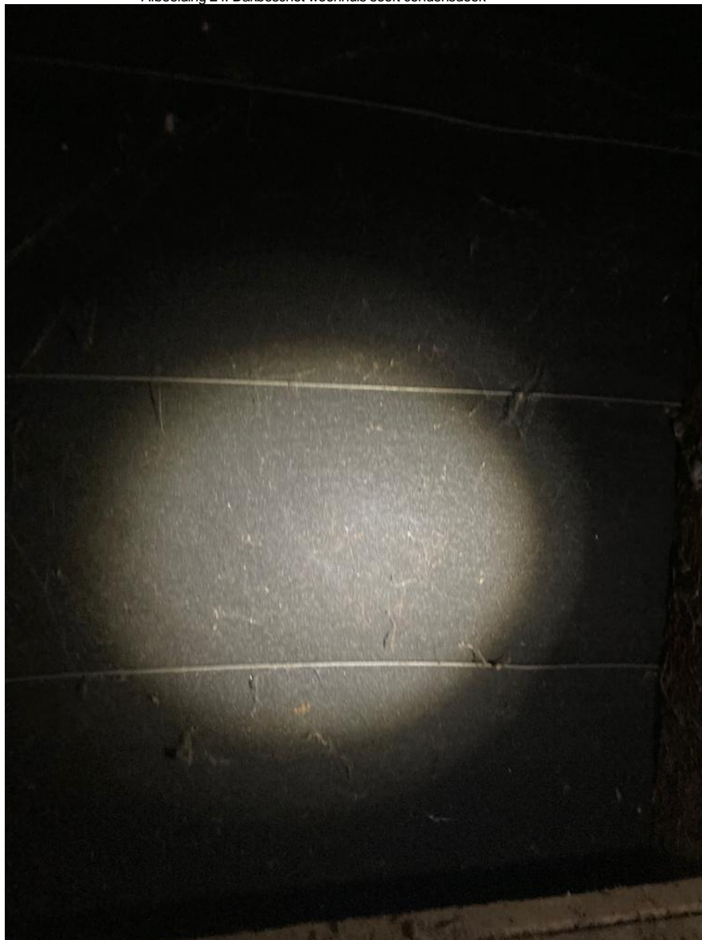
• Afbeelding 24: Dakbeschot woonhuis soort condensdoek
