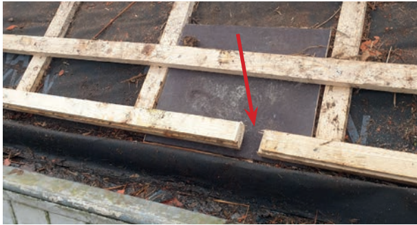
Figuur 15. Invliegopening panlat huismus en houtplaat op de dampwerende folie, eerste rij dakpannen.
