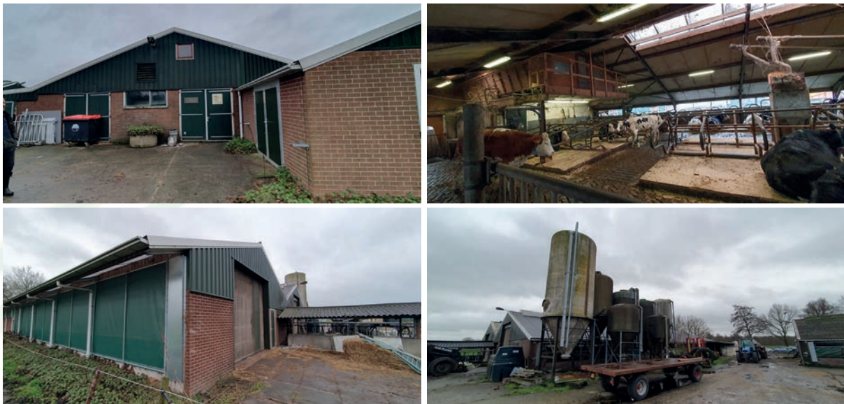
Figuur 2-5. Het oostelijk gelegen gebouw (ligboxstal en melkput).
