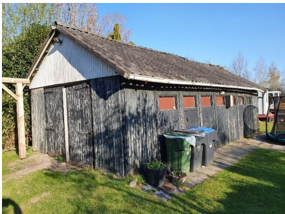
Schuur voorzijde + achterzijde
