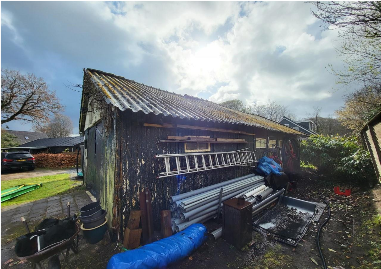
(0.3 Linkerzijde (bestaande) schuur met een golfplaten dakbedekking)
