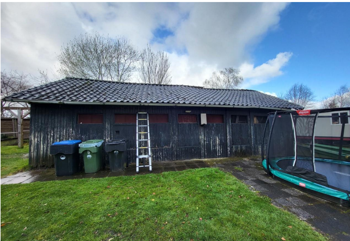
( 0.2 Rechterzijde (bestaande) schuur met het pannendak)
