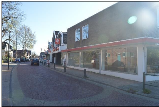
Afbeelding 2.2. Pand gezien vanaf zuidwesten.
