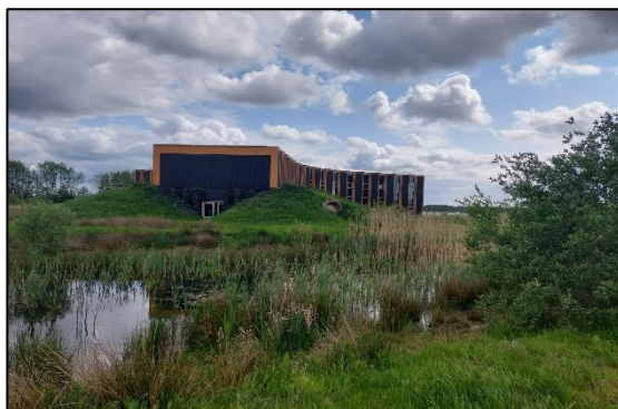
Afbeelding 2.6. Westelijk deel met bedrijfspan, watergang en rechts in de heuvel een vleermuisbunker.
