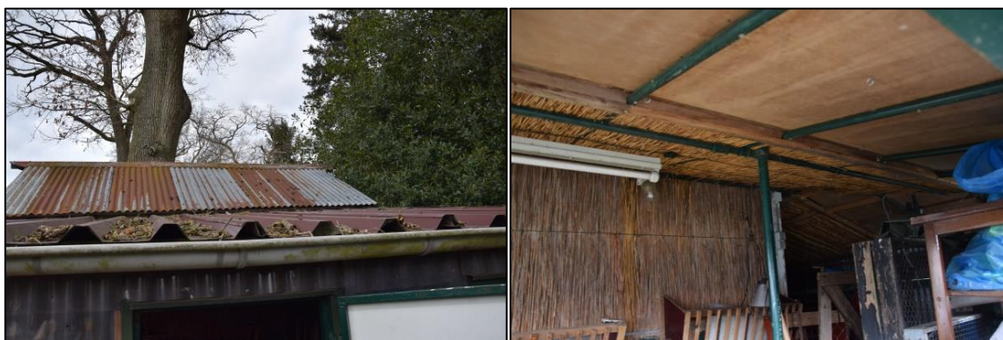
Foto's 5 en 6. Links het lage damwandplaten dak van het schapenstalletje gezien van buiten. Rechts de binnenkant van het damwandplaten dak van het schapenstalletje.
