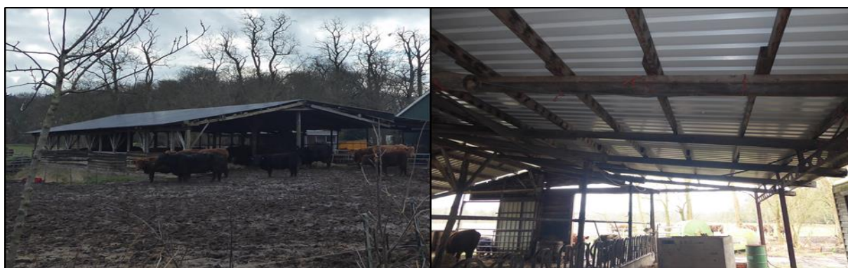
Figuur I.2. Te slopen open koeienstal (nr. 2).
