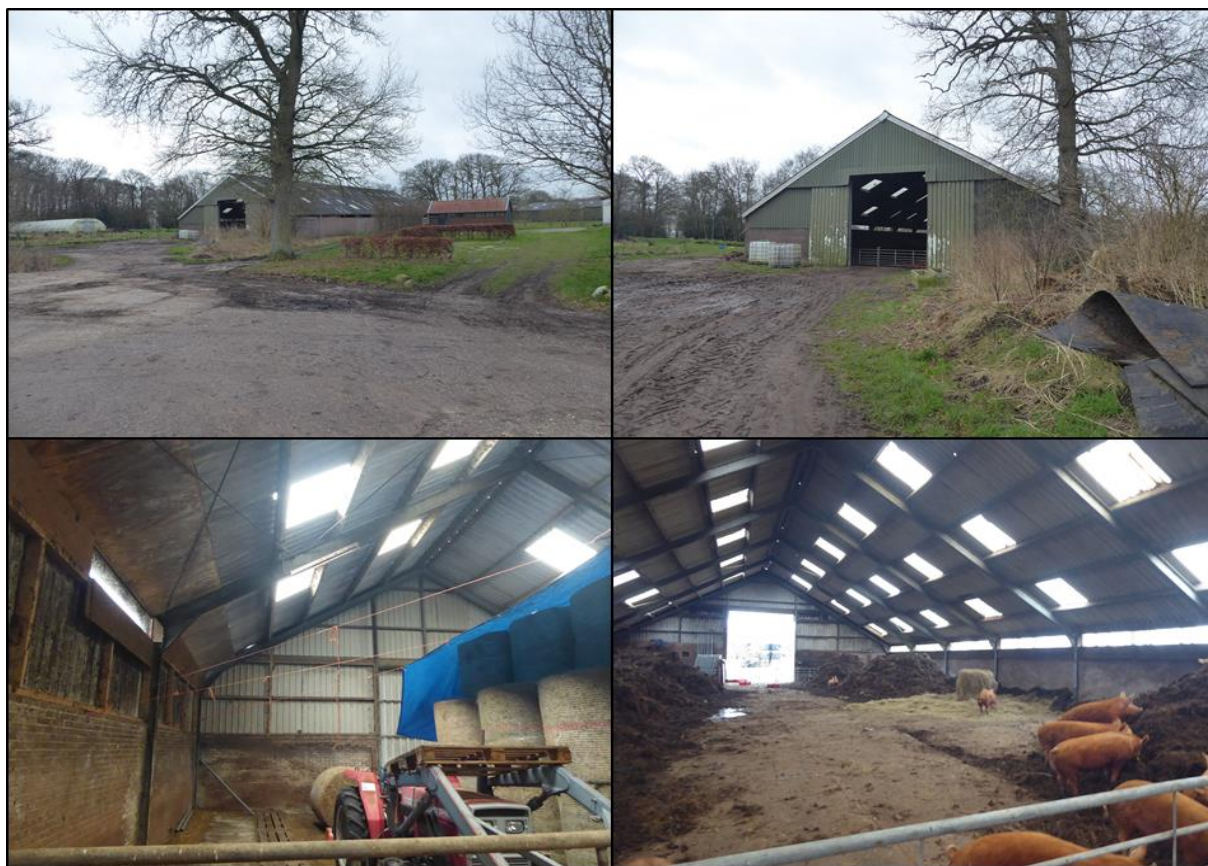
Figuur I.1. Te slopen varkensstal (nr. 1).
