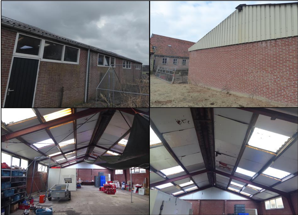
Figuur I.6. Te slopen loods (nr. 6).
