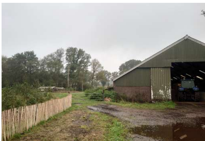
De te slopen schuur gezien vanuit het noordoosten
