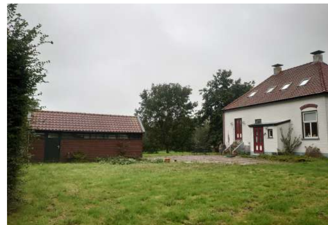
Achterzijde villa nr. 25
