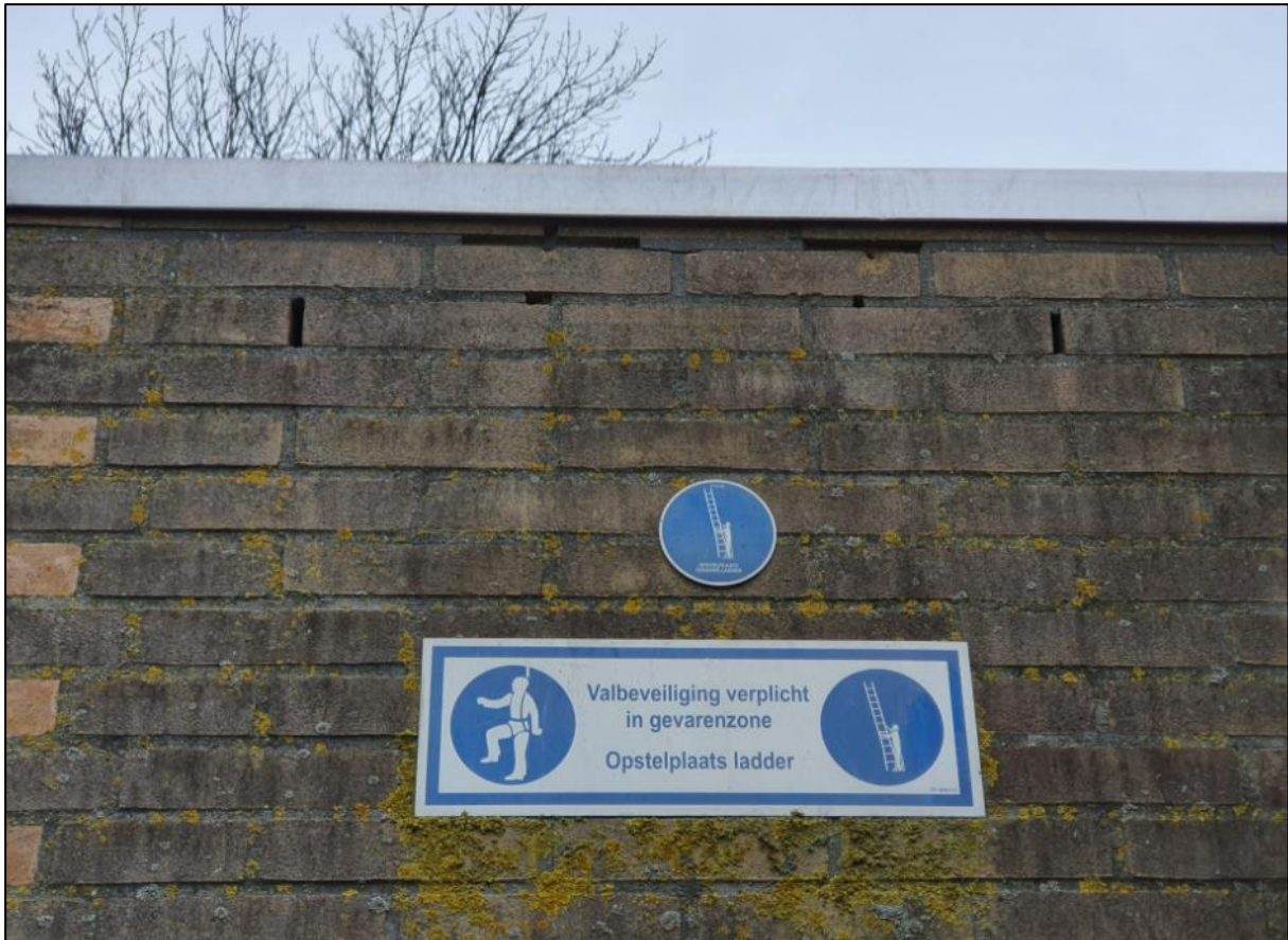
Figuur 2.5.: In de muren van de peuterspeelzaal zijn stootvoegen aanwezig.
