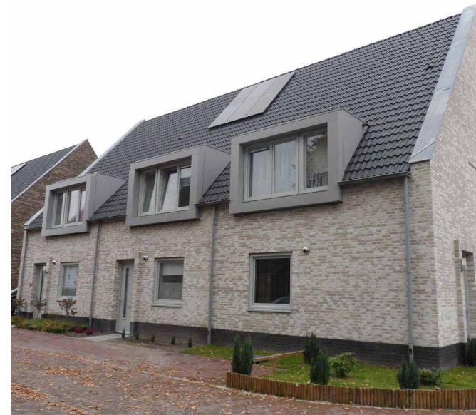
Gevel in grijstoon, kozijnen met weinig contrast
