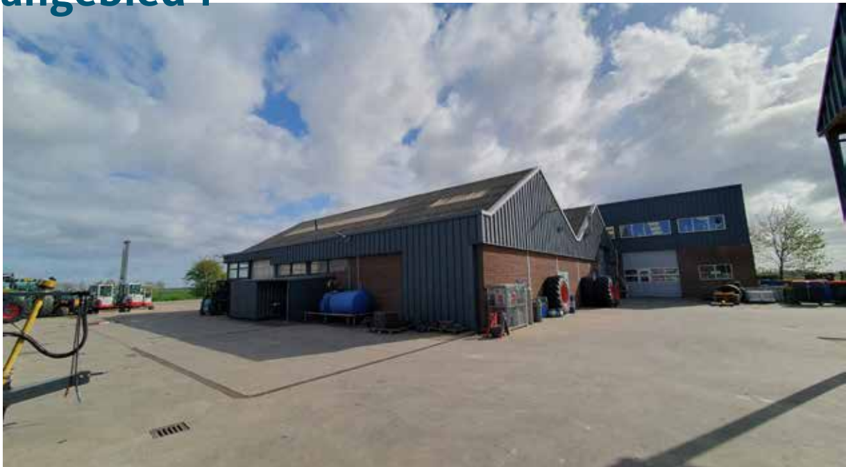
Figuur 3. De achterzijde van het hoofdpand, zuid- en westzijde.
