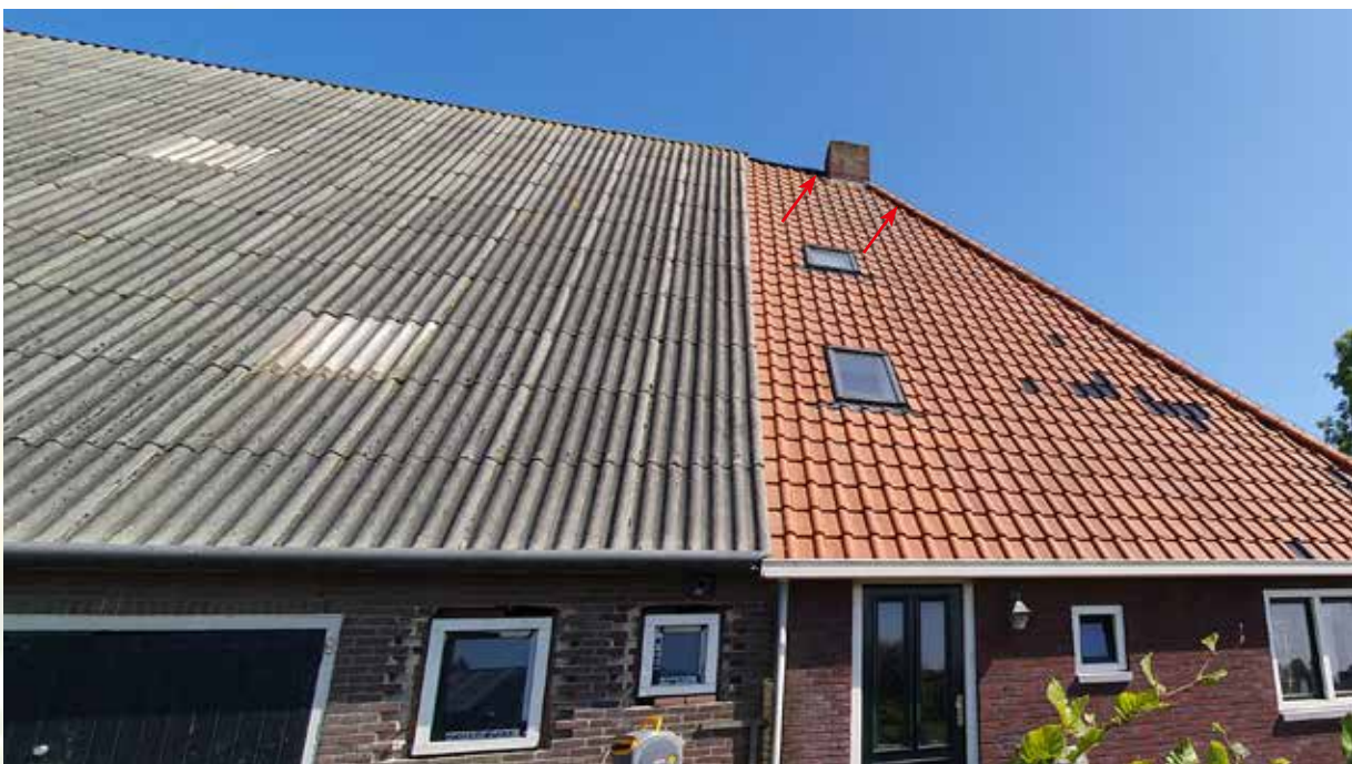
Figuur 17. Invliegopeningen vleermuizen (rode pijlen) in het dak van het woondeel van de boerderij.
