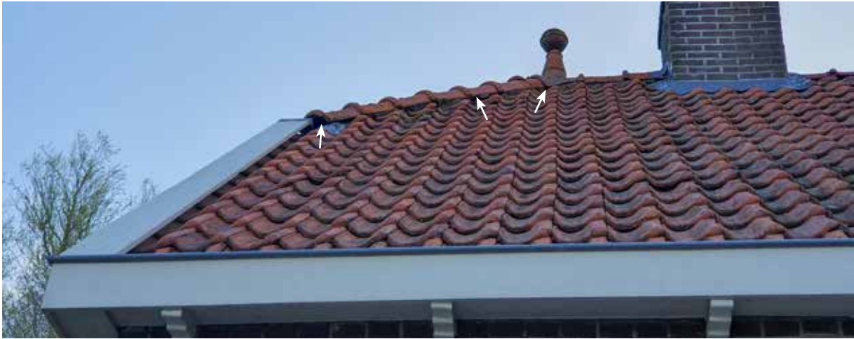
Figuur 16. Invliegopeningen vleermuizen (en huismus) in bedrijfswoning aan de noordoostzijde.
