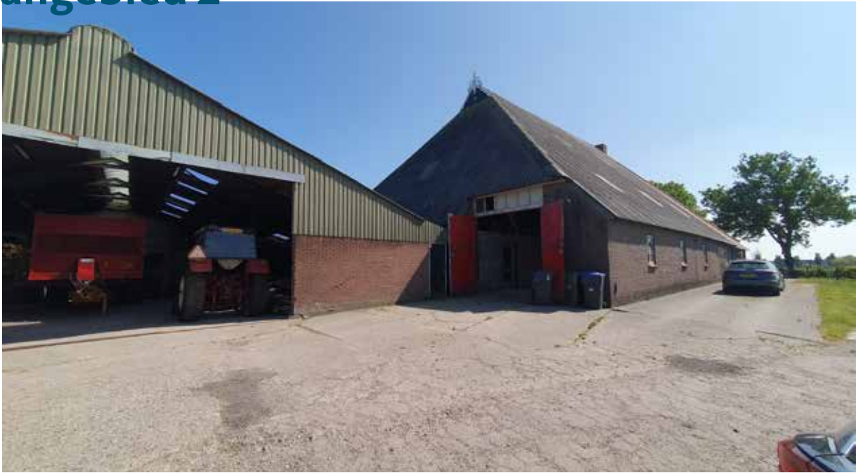
Figuur 11. Links te slopen noorderlijk gelegen schuur, rechts de woonboerderij.
