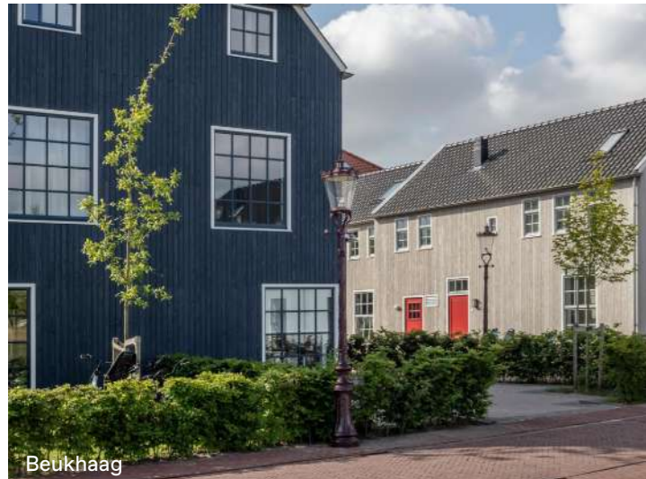
Tuinmuren als erfafscheding aan de straat
