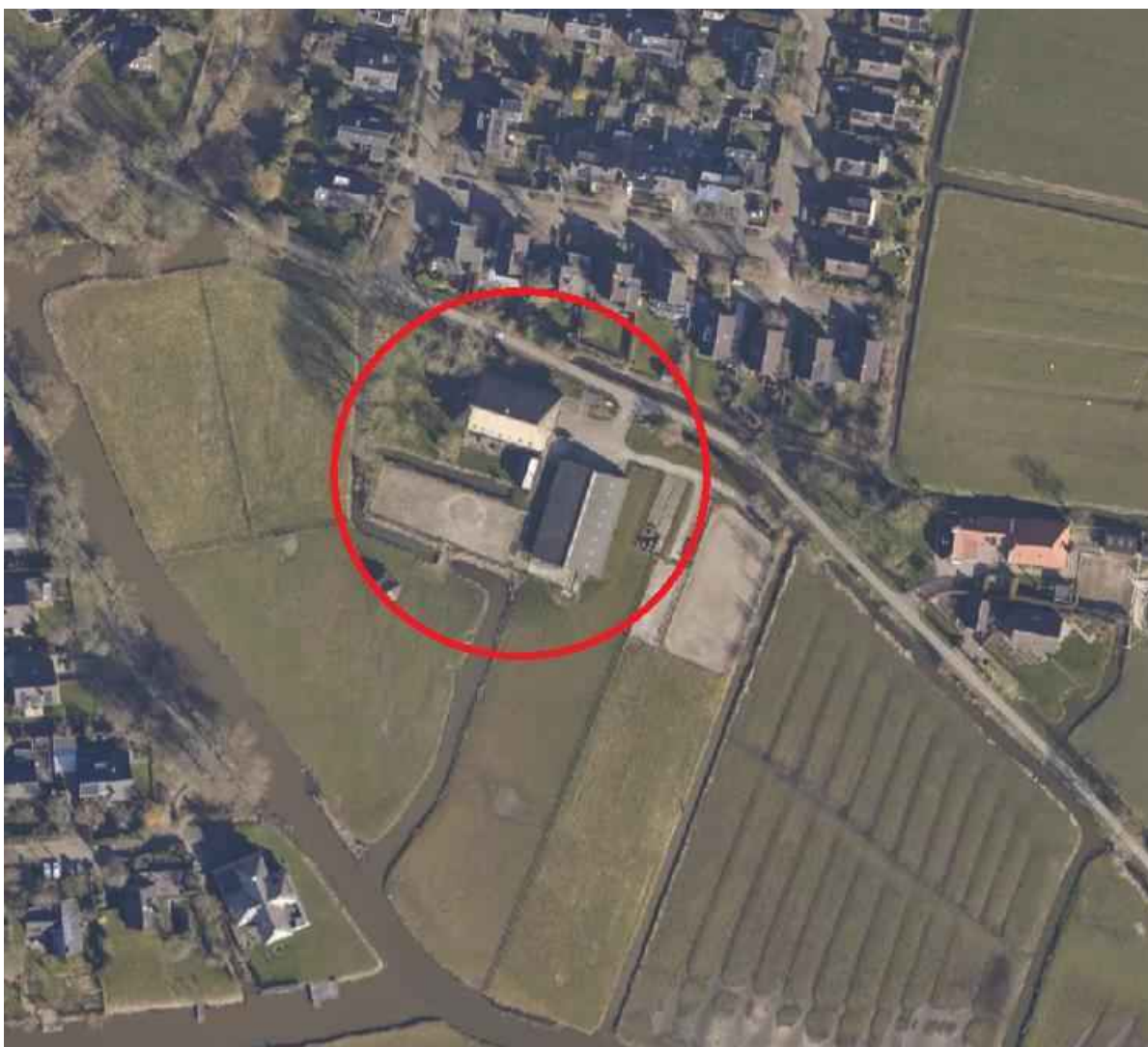
Figuur 1 Hounsdyk 6 te Goutum. De loods aan de oostkant zal worden gesloopt.
