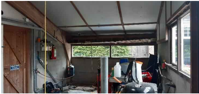
Figuur 3.12: Binnenzijde wasruimte.
