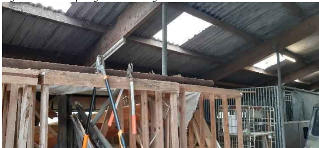
Figuur 3.10: Binnenzijde ligboxenstal.
