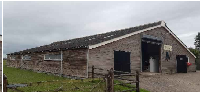
Figuur 3.3: Noordoostelijke zijde ligboxenstal.
