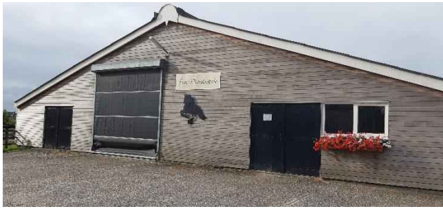
Figuur 3.2: Vooraanzicht te slopen ligboxenstal.
