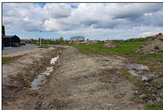
Afbeelding 2.6. Sloot welke is uitgegraven aan de westzijde van het plangebied.
