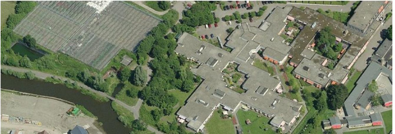
Kassen en bebouwing Parkhove
